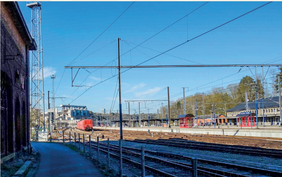
Gare et industrie Lhoist.
