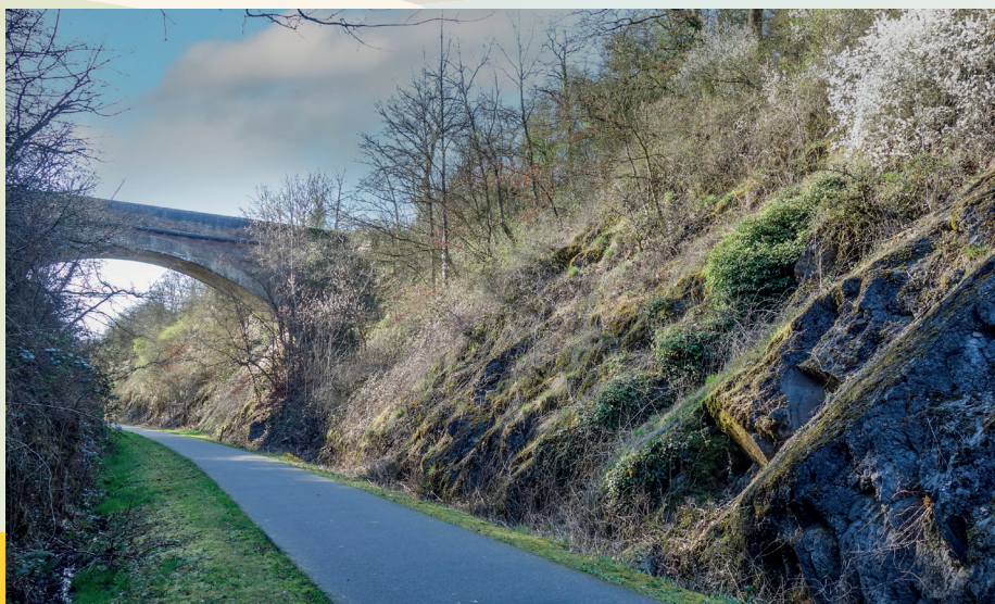
Le RAVel lors de son passage en tranchée dans les roches détritiques de l'eifélien.
